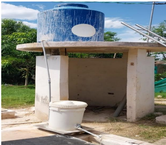
Imagen N° 81: Sistema de cloración por goteo y sistema de cloro gas sin funcionamiento
