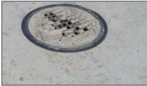
Imagen N° 88: Buzones colapsados por atoro de colector e ingreso del drenaje pluvial.
