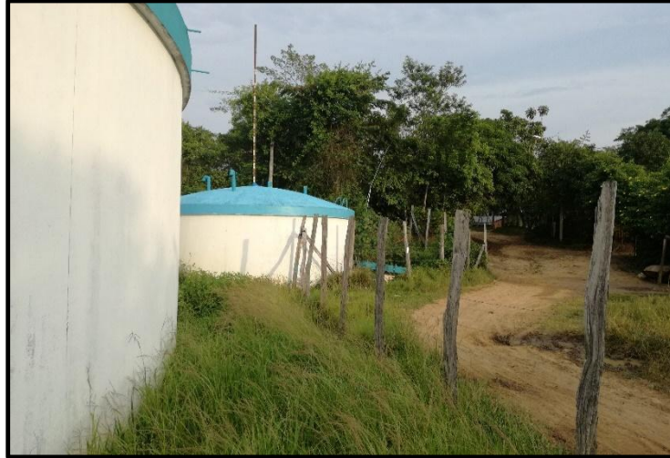
Imagen N° 41: Vista del reservorio R-120
