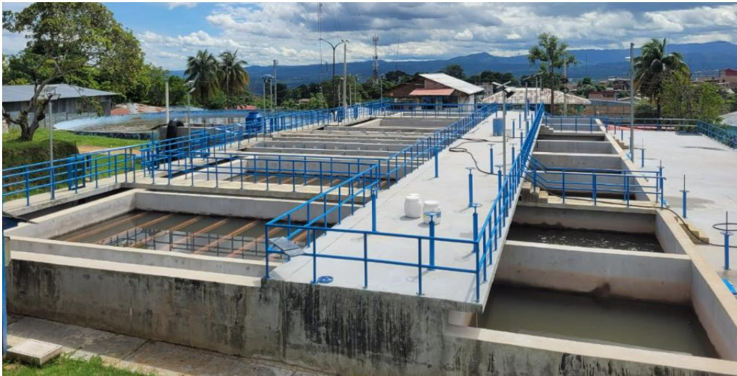
Imagen N° 30: Vista de la PTAP Cachiyacu II
