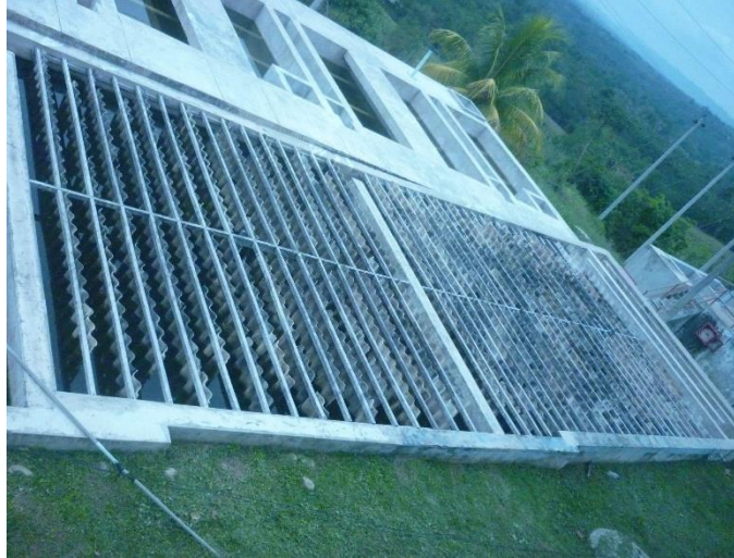
Imagen N° 48: Vista del Flocculador
