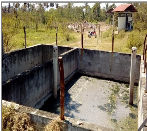
Imagen N° 90: Planta de tratamiento de aguas residuales PTAR Caspizapa colapsada.
