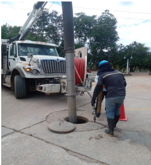
Imagen N° 89: Mantenimiento de los Buzones con el Hidrojet
