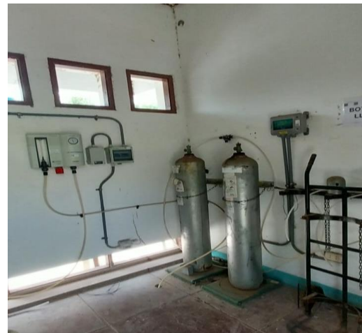
Imagen N° 81: Sistema de cloración por goteo y sistema de cloro gas sin funcionamiento
