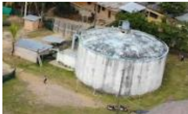
Imagen N° 36: Vista del reservorio R-900
