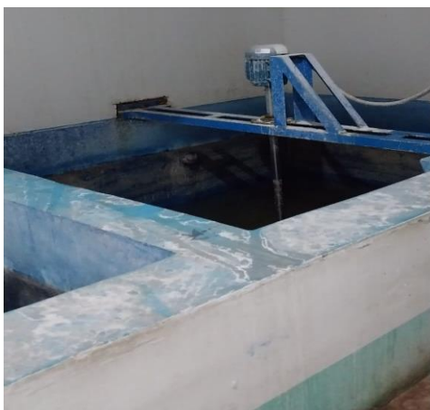
Imagen N° 75: Tanque de solución existente y dosificadores
