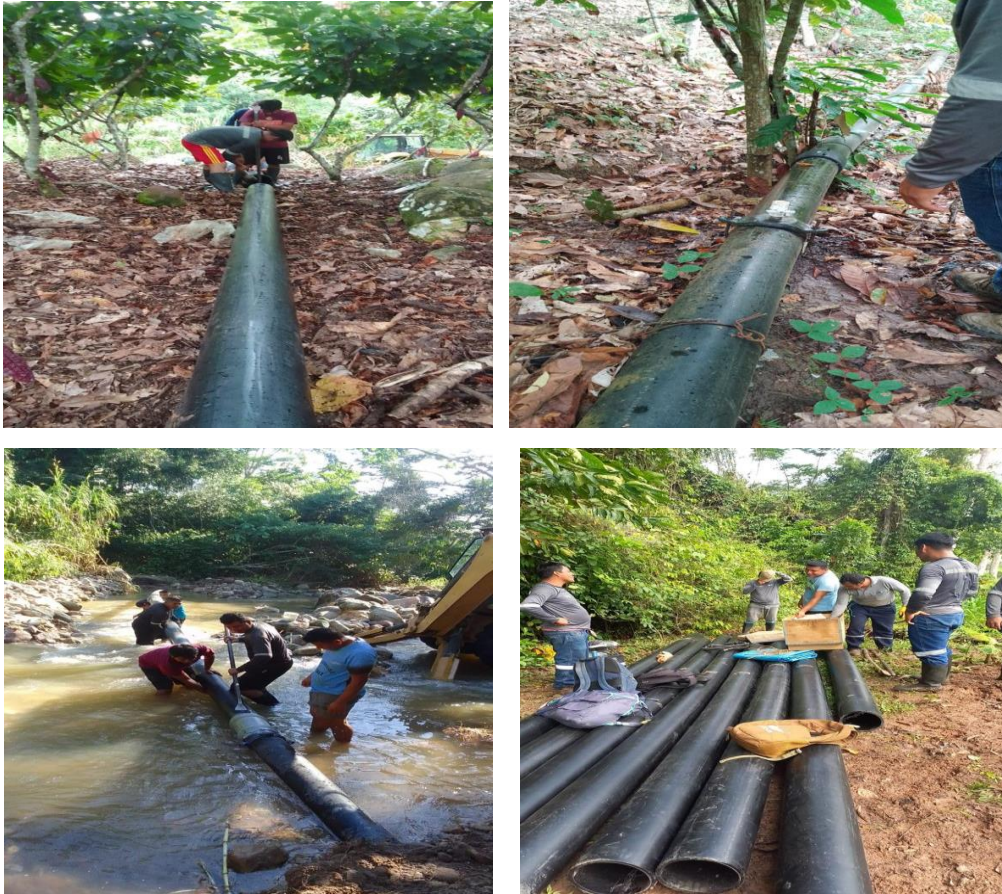
Imagen N° 58: Línea de Conducción Después de un Deslizamiento de Terreno
