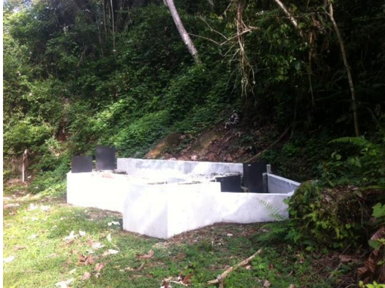
Imagen N° 45: Vista del pretratamiento
