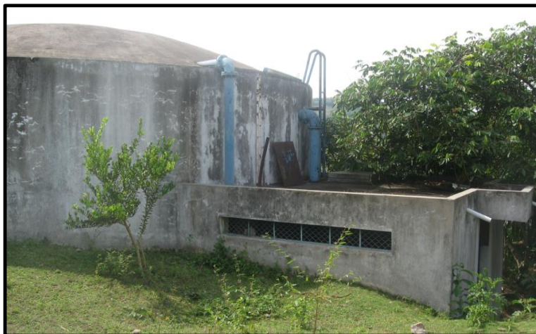
Imagen N° 61: Vista del reservorio de 500 m3
