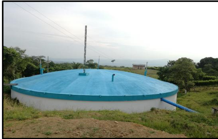
Imagen N° 40: Vista del reservorio R-2800
