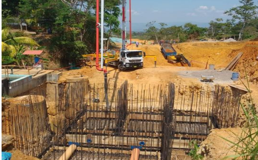
Imagen N° 32: Vista de la PTAP Ahuashiyacu en proceso de obra de mejoramiento
