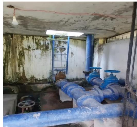
Imagen N° 84:: Reservorio de 250 m3 caseta de válvulas.
