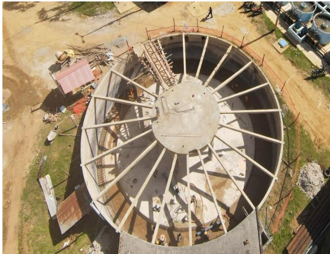
Imagen N° 35: Vista del reservorio R-1256 en obra
