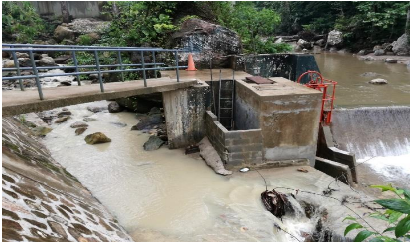
Imagen N° 19: Vista de la quebrada Ahuashiyacu
