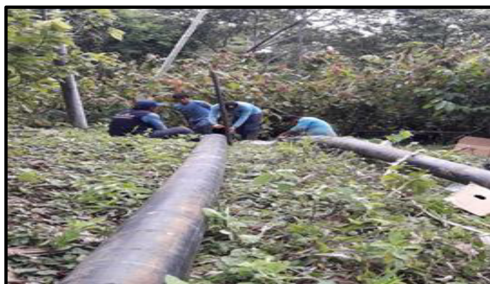
Imagen N° 58: Línea de Conducción Después de un Deslizamiento de Terreno
