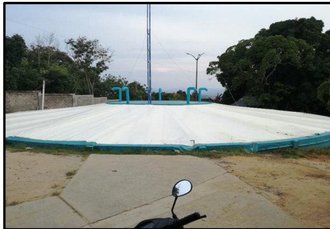
Imagen N° 34: Vista del reservorio R-1256
