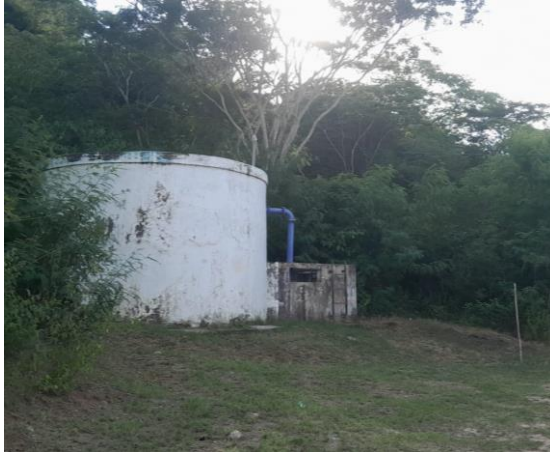
Imagen N° 83: Reservorio de 90 m3 y caseta de válvulas.
