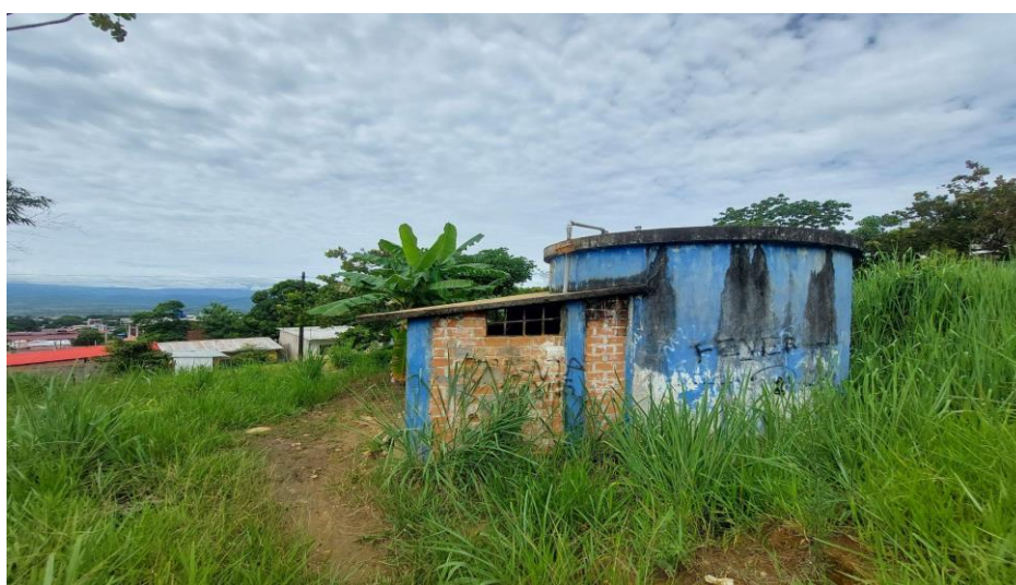
Imagen N° 43: Vista del reservorio R-54
