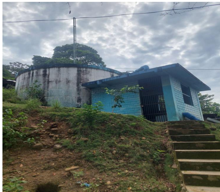
Imagen N° 42: Vista del reservorio R-100
