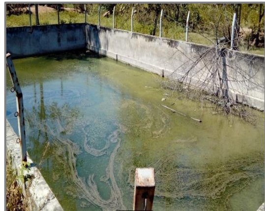
Imagen N° 90: Planta de tratamiento de aguas residuales PTAR Caspizapa colapsada.
