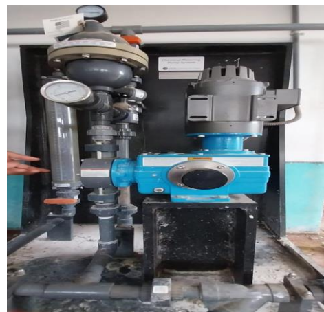
Imagen N° 75: Tanque de solución existente y dosificadores
