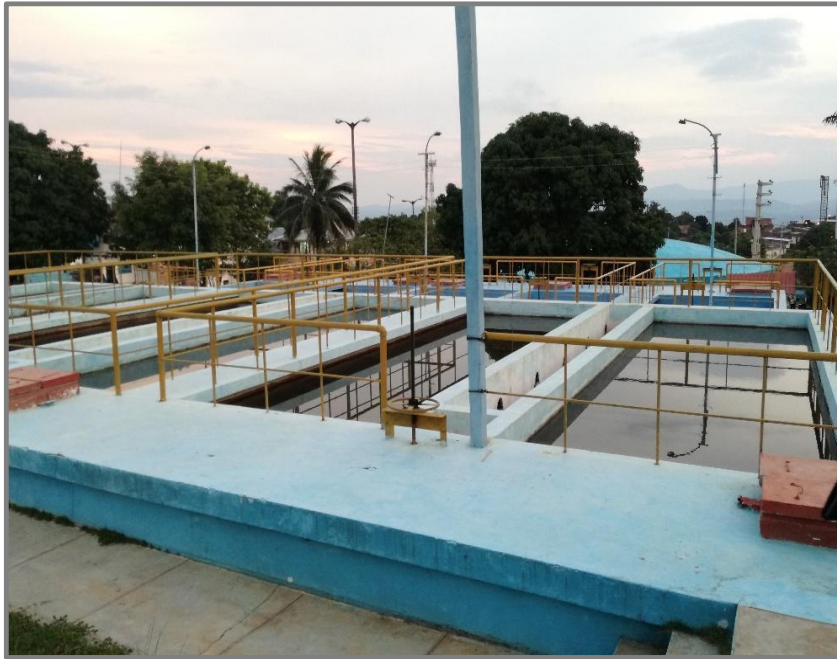
Imagen N° 28: Vista de la PTAP Cachiyacu
