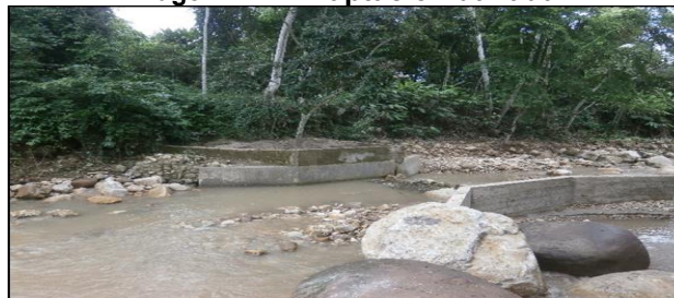
Imagen N° 14: Captación dañada
