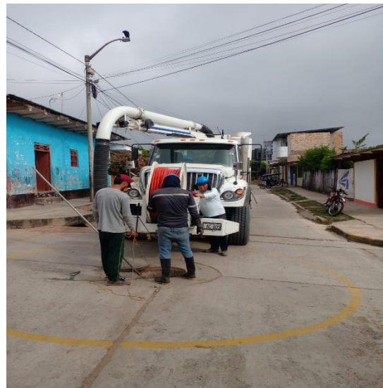
Imagen N° 89: Mantenimiento de los Buzones con el Hidrojet
