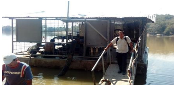
Imagen N° 12: Captación de balsa flotante
