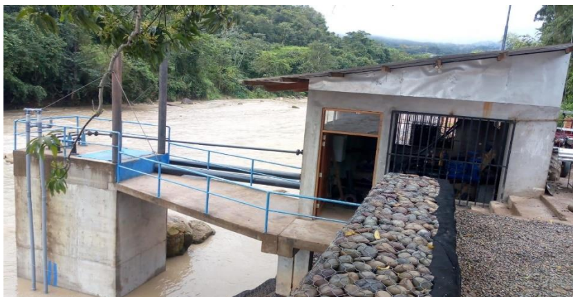
Imagen N° 24: Vista de la Captación Cumbaza
