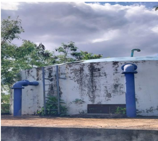
Imagen N° 84:: Reservorio de 250 m3 caseta de válvulas.
