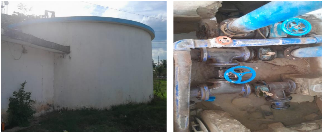
Imagen N° 85: Reservorio de 350 m3 y caseta de válvulas
