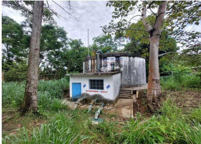
Imagen N° 39: Vista del reservorio R-520
