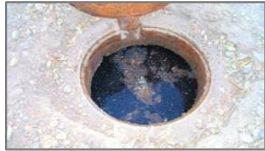
Imagen N° 88: Buzones colapsados por atoro de colector e ingreso del drenaje pluvial.
